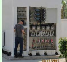
COLD BOX GROUND LEVEL VALVES AND INSTRUMENT VALVES
